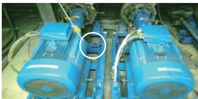
用例: 电机泵组合状态监测
